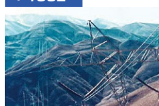
イラン大型送電線工事完成
