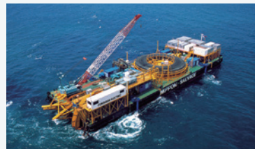
海底送電線敷設工事
