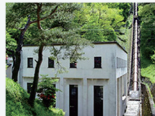
上の代発電所
