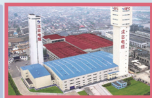
生産工場 瀋陽古河電纜有限公司
